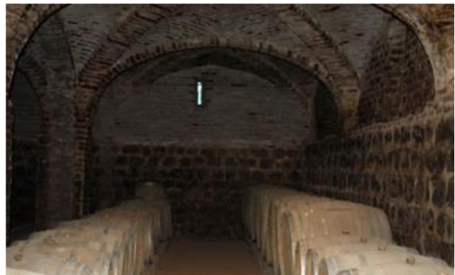
Figura N°61. Túneles Viña Santa Rita
